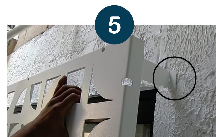
Instalação com Chumbador :
