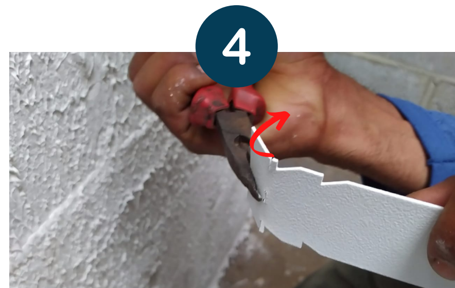
Instalação com Chumbador :
